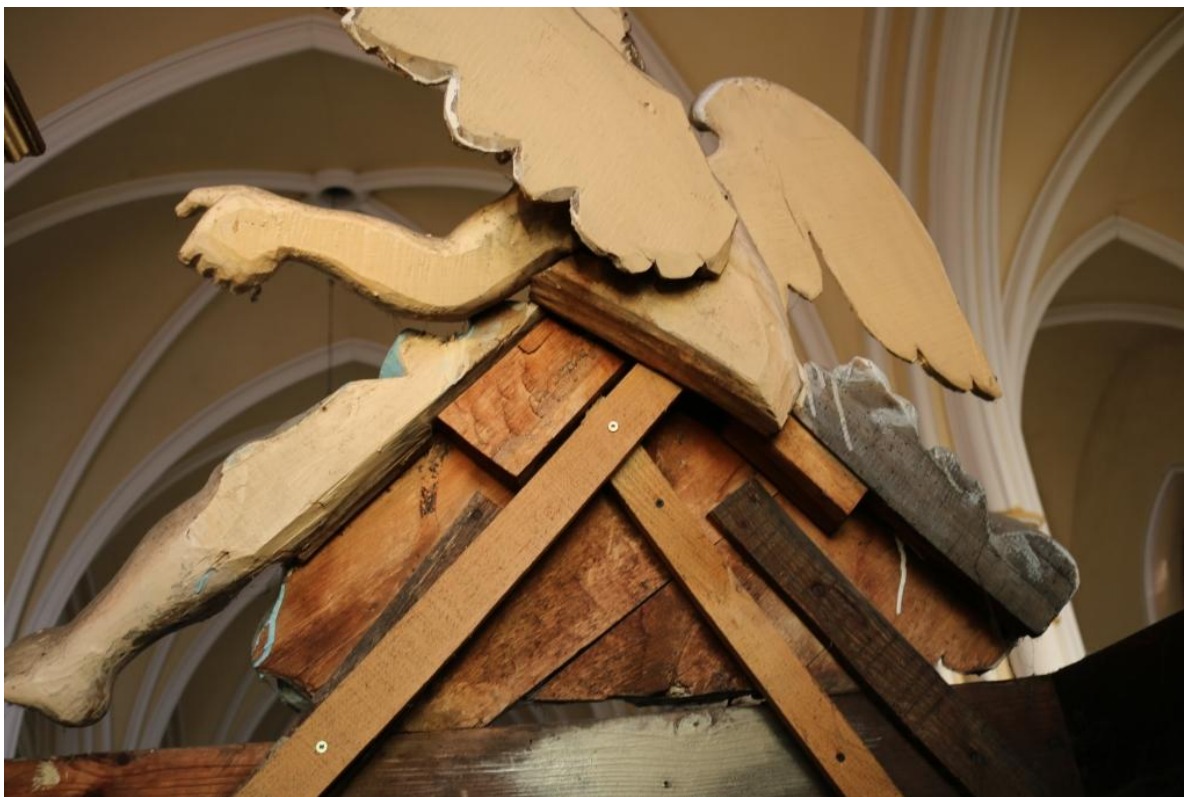
Fot.9. Widok na prowizoryczne mocowanie anioła usytuowanego na szczycie szafy organowej;
