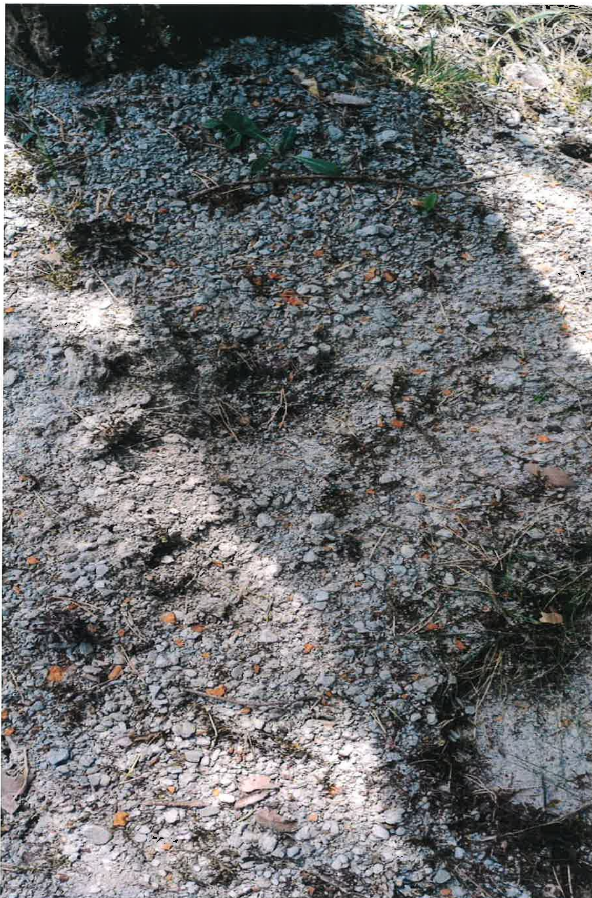
Fot. Osad wydobyty przez Użytkownika ze studni przy użyciu air liftu (ok. 2 tygodnie przed kamerowaniem).
