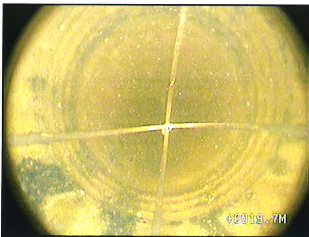
Fot. Widok połączenia kołnierzowego.
