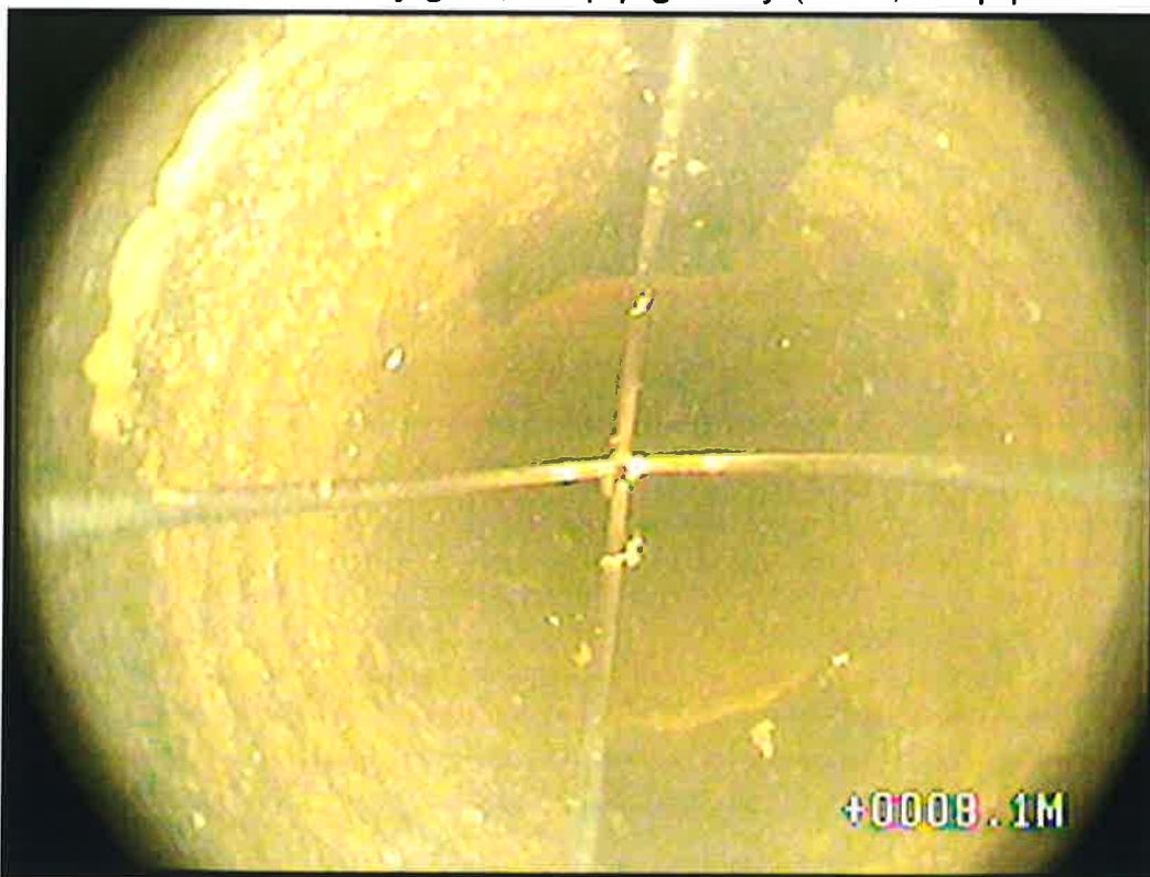
Fot. Widok wylotu z rury nadfiltrkowej z wyciętym zamkiem bagnetowym, zanurzenie kamery gł. 8,1 p.p.głowicy.
