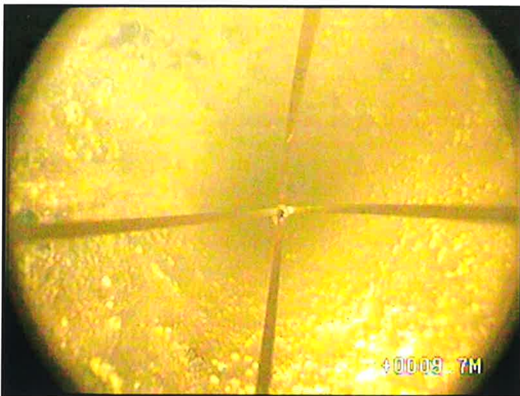
Fot. Rura nadfiltrowa, górny odcinek, zanurzenie kamery gł. 9,7 m p.p.głowicy (ok.11,5 m p.p.terenu).
