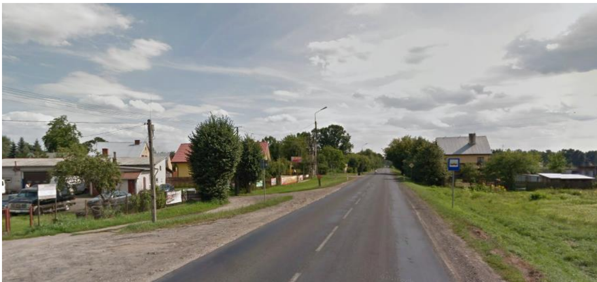
Rysunek 3.17. Droga krajowa nr 50 na odcinku Sadowne – Łochów w miejscowości Sadowne ( https://maps.google.pl/ )
