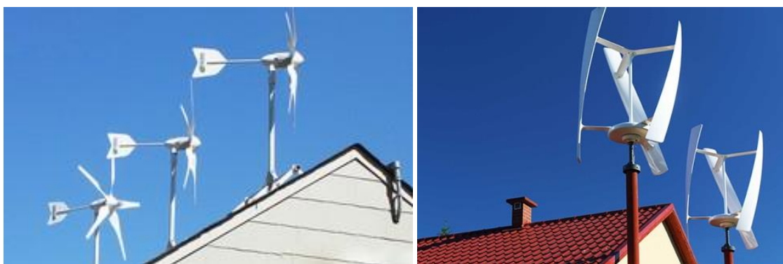
Rysunek 10. Przykłady małych turbin wiatrowych. Po prawej z poziomą osią obrotu, po lewej z pionową osią obrotu
